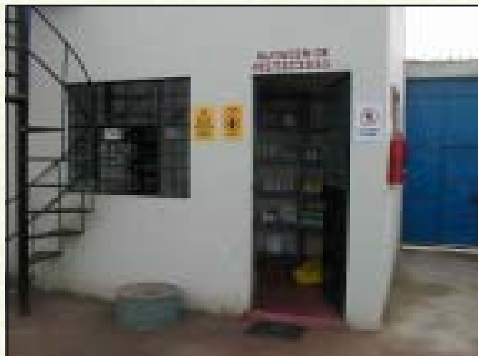
Foto 36: Extinguidor, señales y arena
