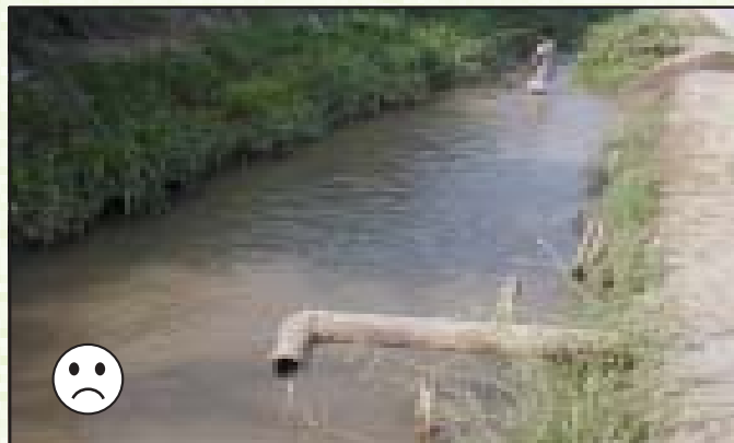
Foto 26: Canal San Miguel, altura del Distrito de San Luis recibiendo descarga de aguas servidas
